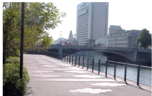
橋詰め空間（万国橋）
