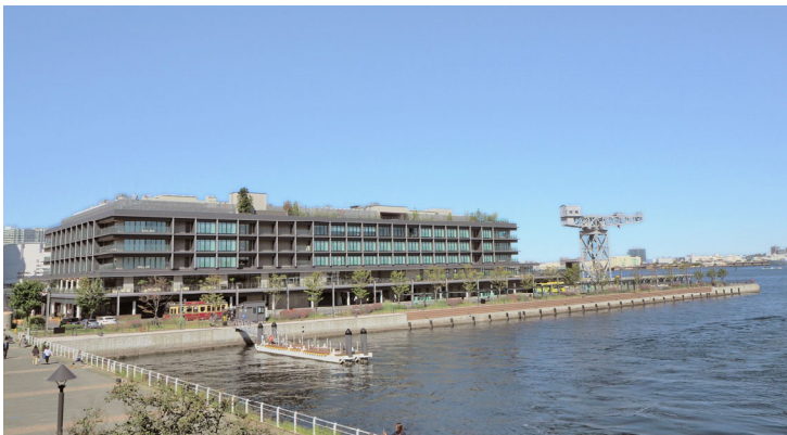
新港ふ頭客船ターミナル
